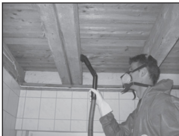
Abb. 8: Feinreinigung im Holzdeckenbereich
