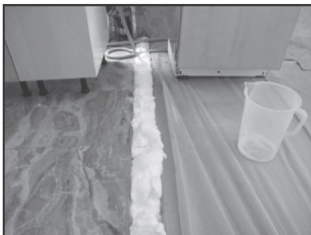
Abb. 7: Schaumdesinfektion nach Rückbau der Trennwand (Anschlussstelle Rohdecke)
