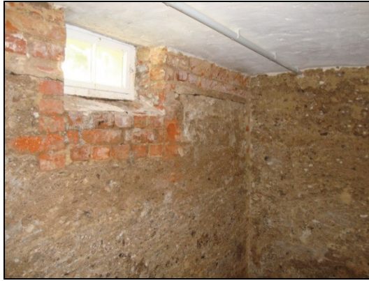
Abb. 5+6: Aufgrund von Wasserströmungen und kapillarer Saugkraft der Ziegel kann es zu Ölkontaminationen in Wandbereichen kommen, welche über dem maximalen Wasserstandspegel lagen. Auch Steig- und Elektroleitungen können der Grund für Öltransport innerhalb des Mauerwerks sein.
