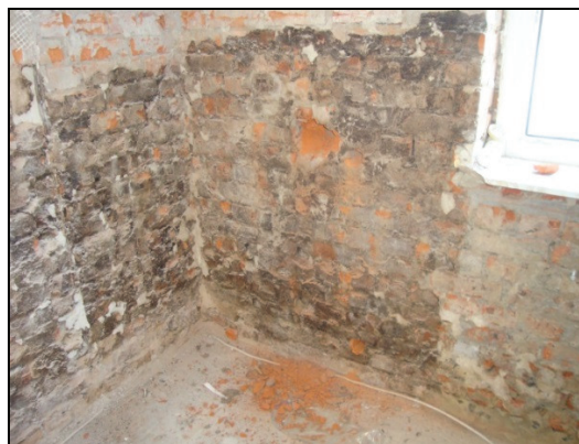
Abb. 3+4: Ein im Zuge der Sanierung eines Altschadens aufgebrachter Bitumen-Anstrich wird von Heizöl aufgelöst.
