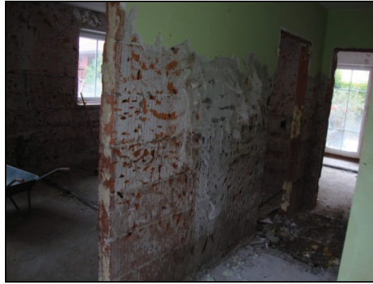
Abb. 5+6: Aufgrund von Wasserströmungen und kapillarer Saugkraft der Ziegel kann es zu Ölkontaminationen in Wandbereichen kommen, welche über dem maximalen Wasserstandspegel lagen. Auch Steig- und Elektroleitungen können der Grund für Öltransport innerhalb des Mauerwerks sein.
