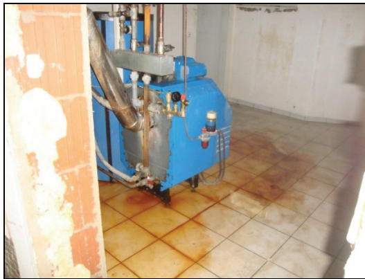
Abb. 1+2: defekte Ölheizanlagen
