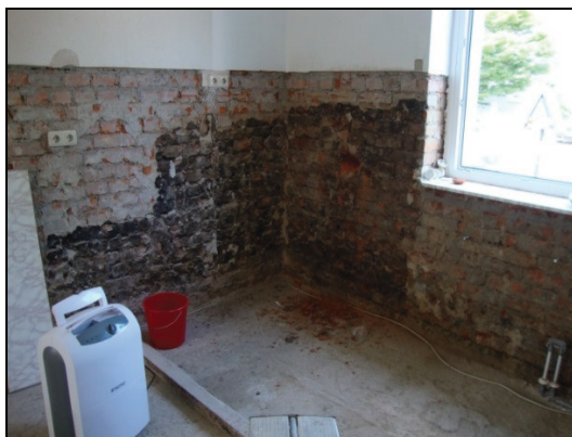
Abb. 3+4: Ein im Zuge der Sanierung eines Altschadens aufgebrachter Bitumen-Anstrich wird von Heizöl aufgelöst.
