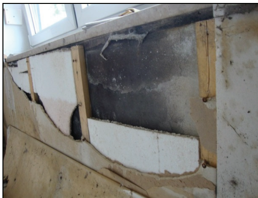
Abb. 7+8: Bei direktem Kontakt zwischen ausgelaufenem Heizöl und der Polystyrol-Dämmschicht, kann diese fast vollständig aufgelöst werden.
