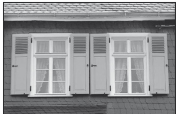
Abb. 1 und 2: Ein Herrenhaus in Frankfurt-Kalbach, erbaut 1663, mit denkmalgerechtem Nachbau der Sprossenfenster mit oberen Kippflügelfenstern (Foto: PaXAG).
