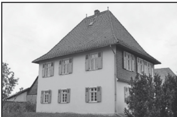
Abb. 1 und 2: Ein Herrenhaus in Frankfurt-Kalbach, erbaut 1663, mit denkmalgerechtem Nachbau der Sprossenfenster mit oberen Kippflügelfenstern (Foto: PaXAG).
