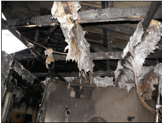
Abb. 11: abgebrannter Dachstuhl
