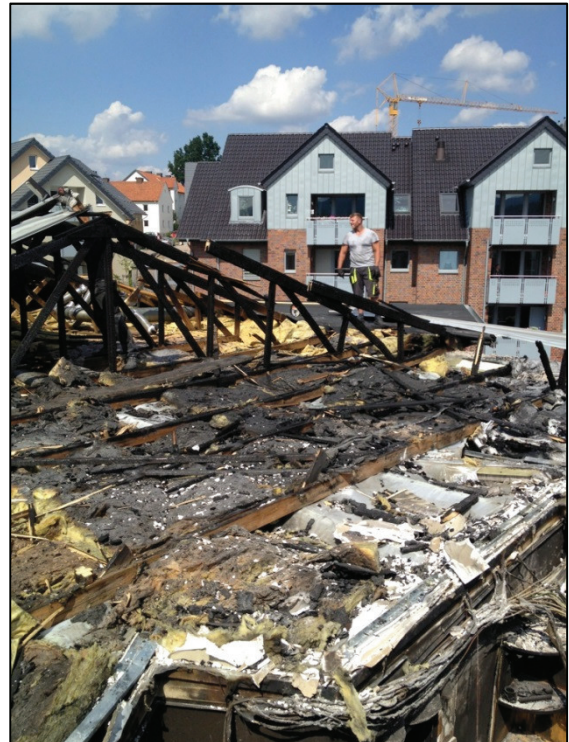
Abb. 18: Aufräums- und Demontagearbeiten
