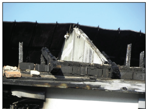
Abb. 15: F30-Trennwand hält über 90 Minuten dem Feuer stand
