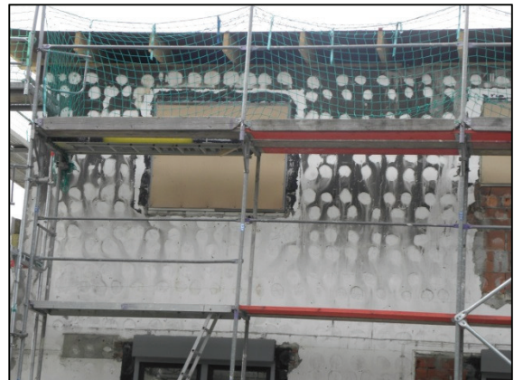
Abb. 19: Fassade nach Entfernung des Wärmedämmverbundsystems
