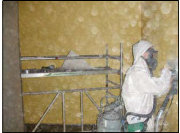
Abb. 16: Mitarbeiter mit Vollschutz beim abschleifen von asbesthaltigen Materialien
