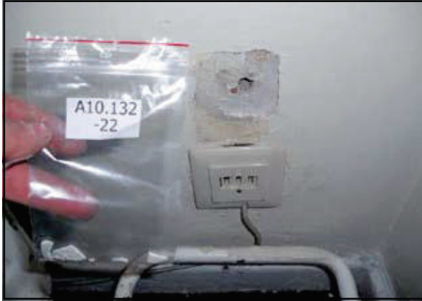
Abb. 13: Füller von Schlitzfen, Ausbesserungen und Reparaturspachtel bei Erneuerungen elektrischer Installationen
