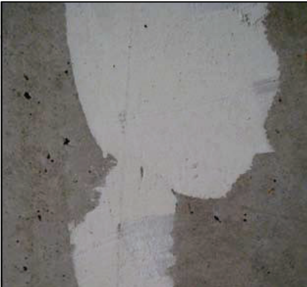
Abb. 8: Fugenfüller und Spachtelungen von Fugen, Stößen und Fehlstellen im Betonbau
