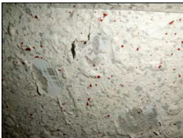
Abb. 3: Flächige Spachtel oder Putz, teilweise unter Spritzbewurf
