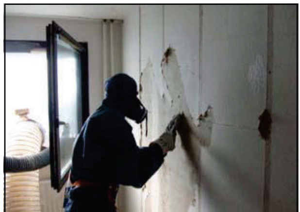
Abb. 17: Mitarbeiter mit Vollschutz beim Abkratzen von Asbesthaltigen Tapeten
