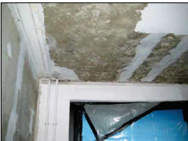
Abb. 18: Betondeckenkonstruktion mit verschiedenen Spachtelmaterialien
