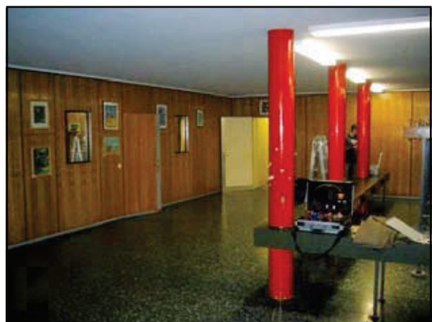
Abb. 6: Flächige Spachtelungen auf Stützen
