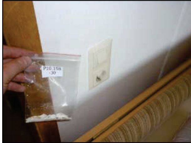
Abb. 10: Fugenfüller und Spachtelungen auf Gipskartonwänden
