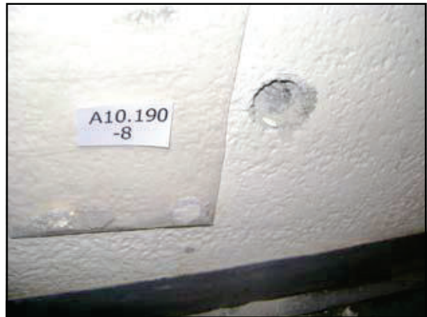
Abb. 4: Flächige Putze unter Feinputz
