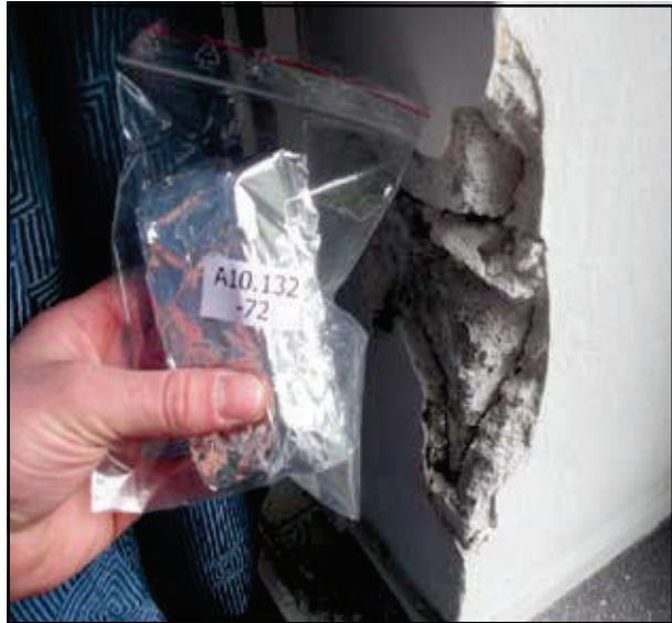
Abb. 11: Ausbesserungen und Reparaturspachtel bei Fassaden Türen- und Fensteraustausch
