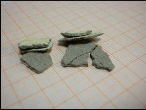
Abb. 7: Putz, Insbesondere, aber nicht ausschließlich, in Verkehrsflächen wie Eingängen, Foyers und Treppenhäusern
