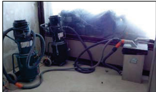
Abb. 28: Absauggeräte, die zur Reinigung der Luft bei Asbestarbeiten unverzichtbar sind
