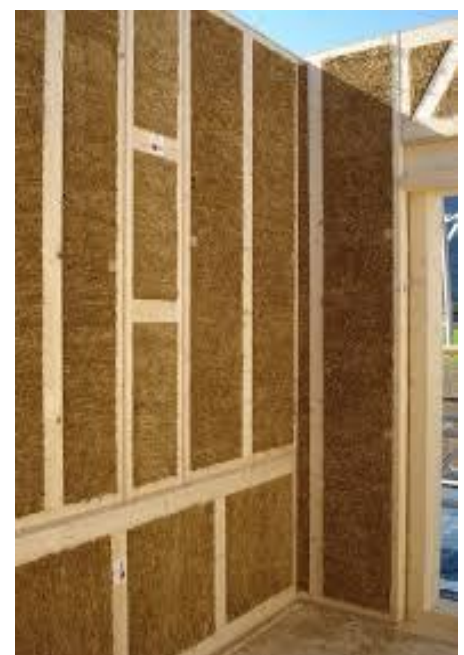
Abbildung 4: Holzstrohwand (baunetzwissen.de)
