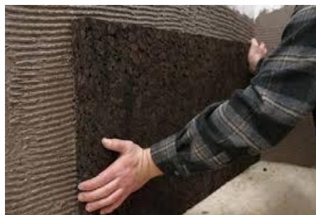
Abbildung 9: Einbau Kork (baunetzwissen.de)
