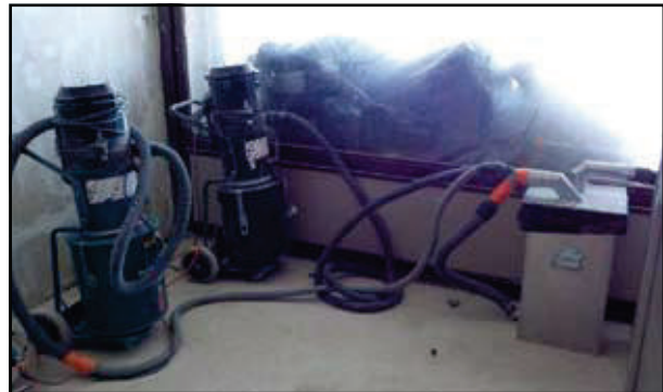
Abb. 28: Absauggeräte, die zur Reinigung der Luft bei Asbestarbeiten unverzichtbar sind
