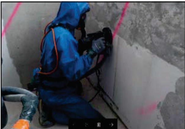
Abb. 27: Mitarbeiter mit Vollschutz beim abschleifen von Asbesthaltigen Materialien
