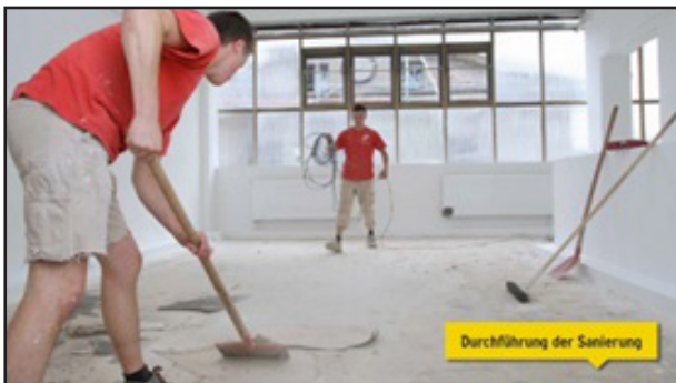
Abb. 1: Ausschnitt aus „Durchführung einer Sanierung“ (Quelle: Leitfaden zur Ursachensuche und Sanierung bei Schimmelpilzwachstum in Innenräumen, Umweltbundesamt 2012, S. 56 – 57, Foto: fotolia.com/khorixas)
