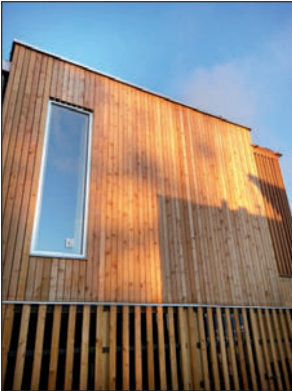
Abb. 2: Testobjekt (finale Bauphase Mai 2014)
