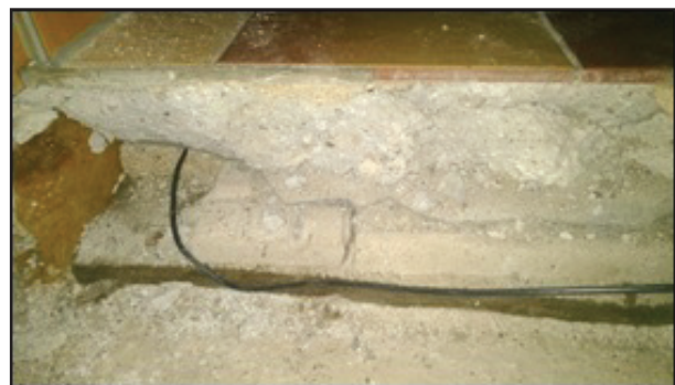
Abb. 3: Gehobene Fliese mit Kleber
