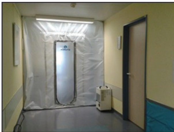
Abb. 4: Sanierungsarbeiten am Gebäude, mit Staubschutzwänden
