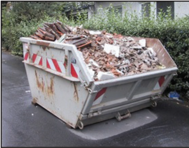
Abb. 7: Container mit Bauschutt
