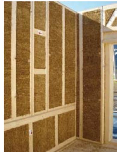
Abb. 4: Holzstrohwand (Quelle: baunetzwissen.de)
