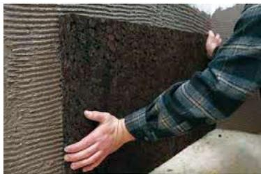
Abb. 9: Einbau Kork (Quelle: [www.baunetzwissen.de](http://www.baunetzwissen.de))
