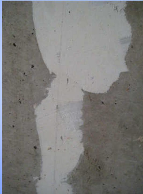
Fugenfüller und Spachtelungen von Fugen, Stößen und Fehlstellen
