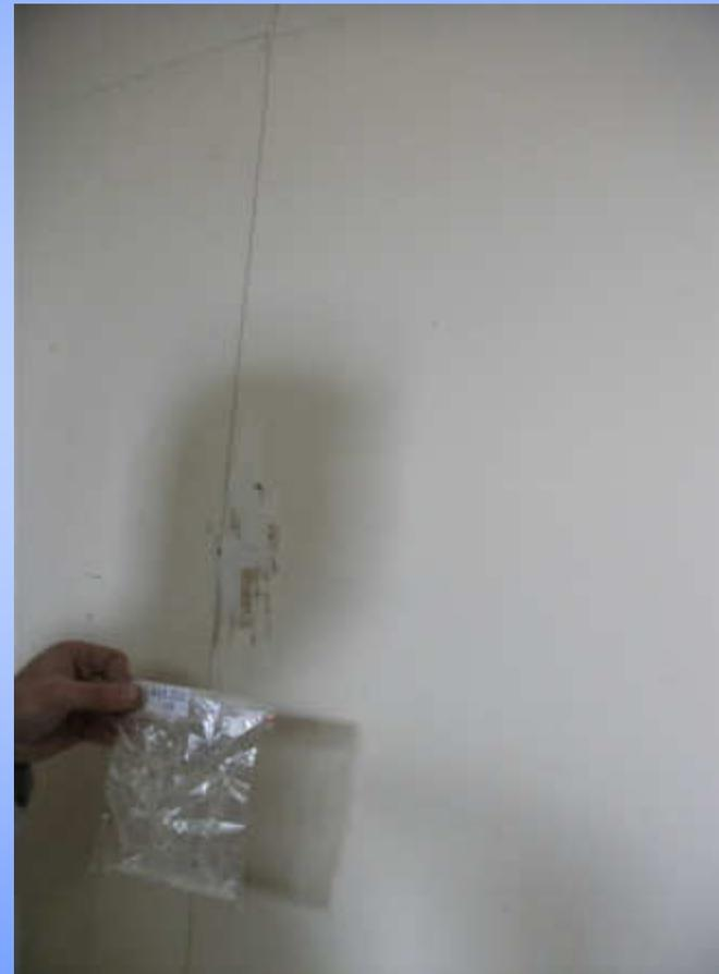
Fugenfüller und Spachtelungen auf Spanplattenwänden
