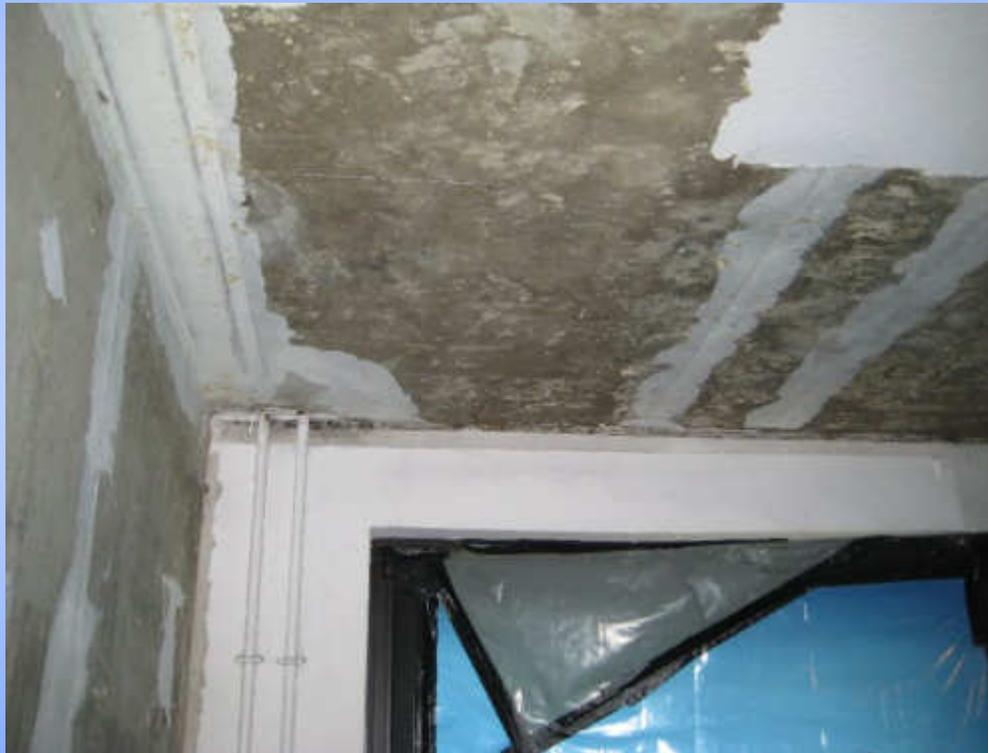
Fugenfüller und Spachtelungen in Schlitzen Tapetenbeton
