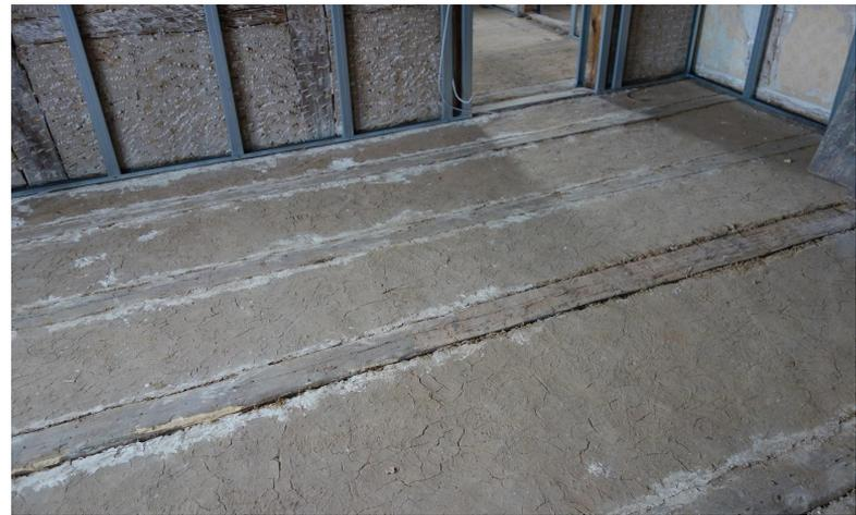
Abb. 7: Alte Holzbalkendecken mit einer Lehmausfachung können Gerüche hervorrufen (Quelle: W. Steinhäuser)
