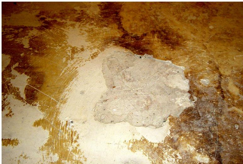
Abb. 2: Alte Restklebstoffe - Hier Sulfitablaugekleber - verursachen immer Gerüche aus dem Altfußboden (Quelle: W. Steinhäuser)
