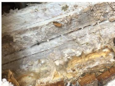
Abb. 5: Holzzerstörender Pilz auf alten Holzkonstruktionen macht sich auch als Geruch bemerkbar (Quelle: W. Steinhäuser)
