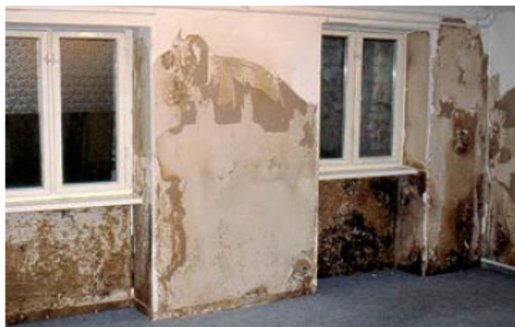
Abbildung 5: Feuchteschaden im Innenraum
