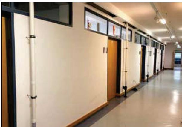
Abb. 3: Radonabsaugleitungen in einem öffentlichen Gebäude/Landratsamt Freyung © RADEA GmbH.
