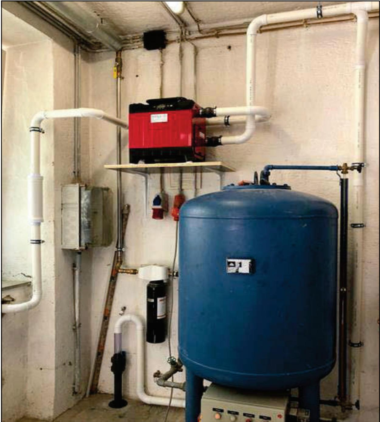
Abb. 2: Radonsauger Corroventa®, fertig installiert mit Ansaug- und Abluftführung © RADEA GmbH
