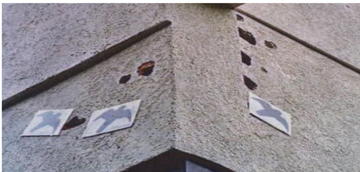
Abb. 6: Spechtlöcher an einem mit WDVS verkleideten Tagungshotel in Norddeutschland (Quelle:<http://www.konrad-fischer-info.de/2134bau.htm>)
