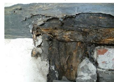
*Abb. 6: Vermoderter Holzbalken nach diffusionsdichtem Anstrich (Quelle: Bild © Die Holzbau Profis)*
