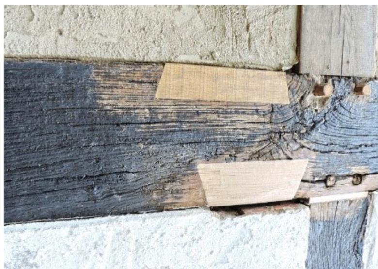
Abb. 5: Fachgerechte Ausbesserung der Holzkonstruktion (Bild © Kramp&Kramp Lemgo)
