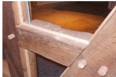
*Abb. 7: Trapezleiste als Wind- und Feuchtebremse (Quelle: Bild © Kramp&Kramp Lemgo)*
