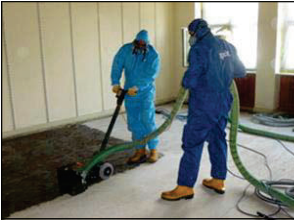
Abb. 3: Entfernung eines PAK-belasteten Parkettklebers in einem Schulgebäude mittels BT-40-Verfahren (links Sanierung eines belasteten Bodens, rechts Parkett mit anhaftendem Kleber) (Quelle Sprint Sanierung GmbH)
