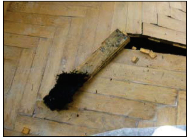
Abb. 3: Entfernung eines PAK-belasteten Parkettklebers in einem Schulgebäude mittels BT-40-Verfahren (links Sanierung eines belasteten Bodens, rechts Parkett mit anhaftendem Kleber) (Quelle Sprint Sanierung GmbH)
