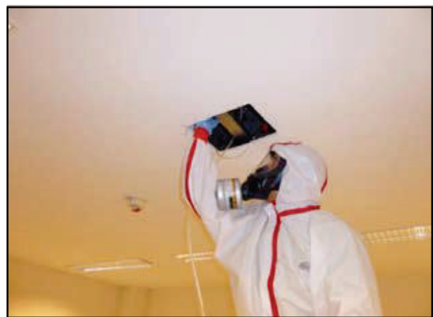
Abb. 7: links: Kaltvernebelung von Wasserstoffperoxid; rechts: Vernebelung des Wirkstoffes in einer abgehängten Decke (Quelle: Sprint Sanierung GmbH)
