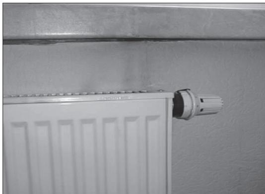
Bild 1: schwarze Ablagerungen am Heizkörper
