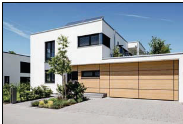
Abb. 2: Kundenhaus Blum: Nachhaltig bauen: Basis ist eine ökologische Gebäudehülle, die vorrangig aus dem natürlichen Werkstoff Holz besteht.
